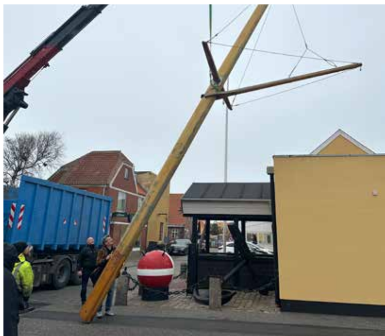
▲ Svær kran grej er nødvendig, når flagmasten foran Skagen Marineforenings marinhushus skal nedtages til renovering. (Foto: Skagen Marineforening.)
