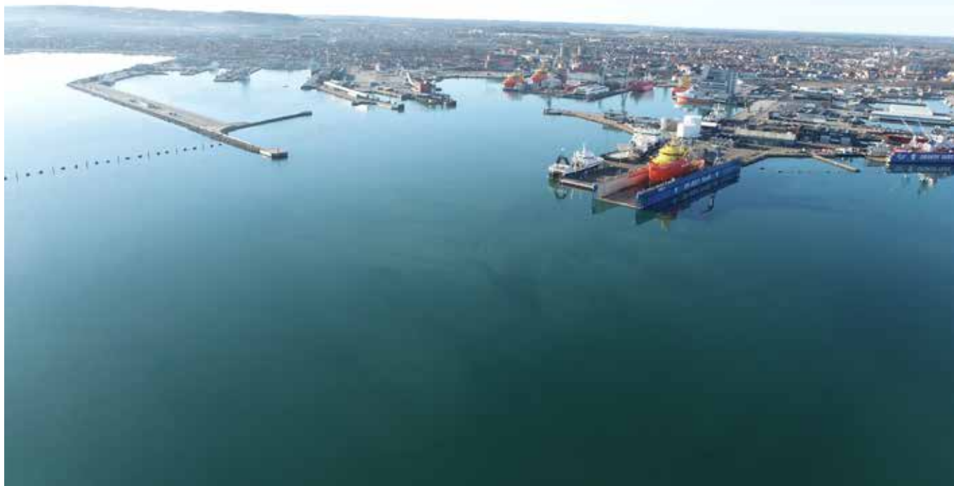
▲ Færgenavnet ses midt i billedet nord for Flådestation Frederikshavn. Den langsigtede aftale mellem Stena Line og Frederikshavn Kommunes giver langsigtede muligheder for begge parter. (Foto: Stena Line)
