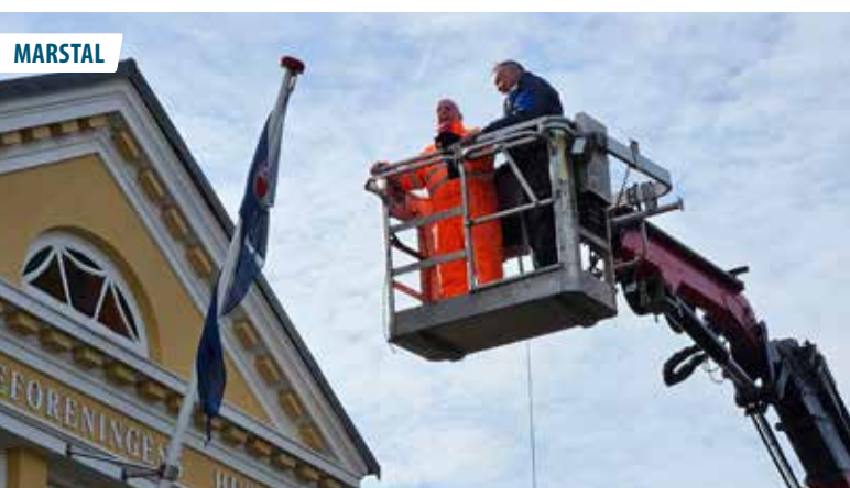
▲ Ifølge det oplyste er det Jens Kop og Jens Ole Weiss, der er på farefuldt montagearbejde ved marinehuset i Marstal. (Foto: Lau Andersen)
