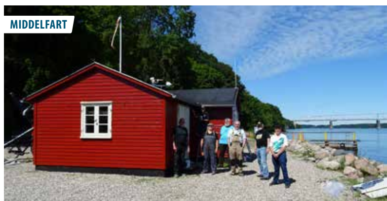
▲ Efter en grundig omgang maling fremstår marinehuset på Sildemarken ved Middelfart så godt som nyt.
