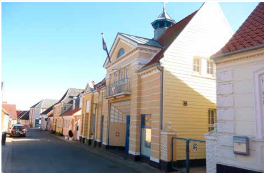
▲ Marinehuset i Marstal er indrettet i en tidligere biograf.
