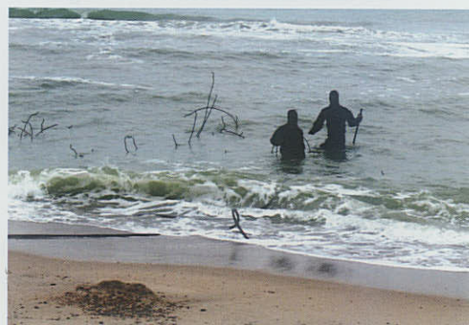
Dykkere arbejder med at montere sprængstofsror på resterne af Fjandbunkeren. Bølgerne her er den største udfordring. (Foto: Kystdirektoratet)
