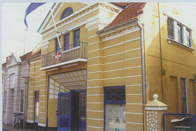
Marineforeningens Hus i Marstal. En fryd for øjet efter at facaden er blevet nyrenoveret.
