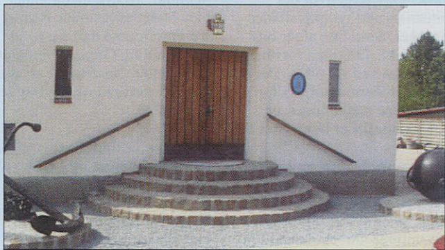
Ny trædesten og nyt indgangsparti til Glyngøre Marinehuset.
