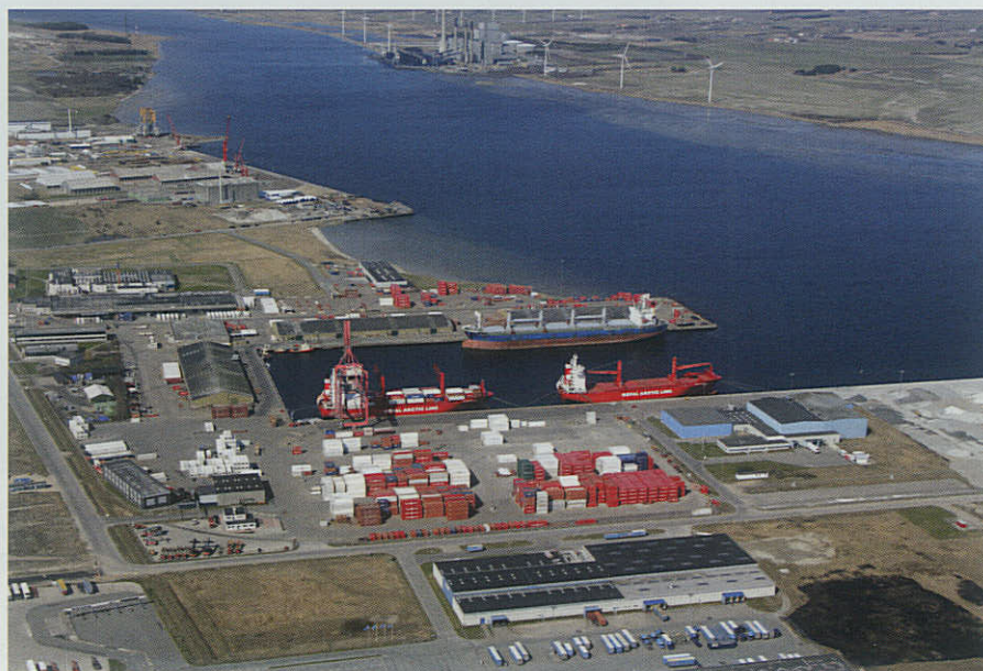
De to røde Royal Arctic Line (RAL) skibe ved Grønlandshavnens østkaj er "Nuka Arctics" og Naja Arctica". Skibene er de to største i RAL flåden og kan på deres 134 meters længde hver laste 782 TEU. (én TEU = én 20 fods containerenhed).
