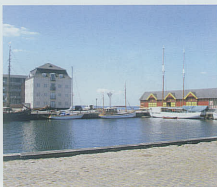
Bolig- og skolebyggeri ved Sønderbassin.
