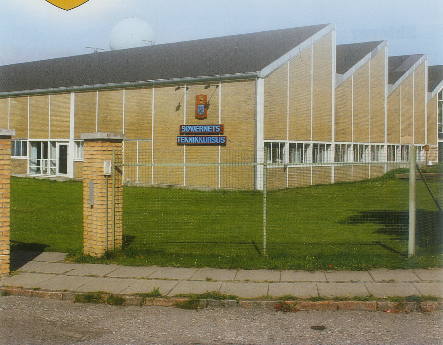
Søværnets Teknikkursus særprægede bygning, der indtil 1993 var Orlogsværftets Elektronikværksted
